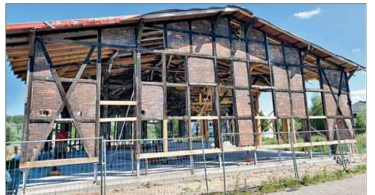
Die tragende Holzkonstruktion des Ringlokschuppens bestehend aus Stützen, Sprengwerk und Dachkonstruktion wurde saniert, wobei auf die Wiederverwendung von beschädigten, nicht mehr tragenden Hölzern ein Hauptaugenmerk gelegt wurde. Der Anteil von neuem Bauholz wurde sehr stark begrenzt.
